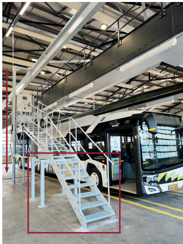
1 er palier fixe de l'escalier
